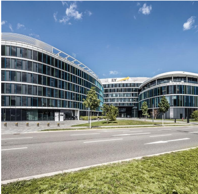
Büro Flughafenstraße 58 in Stuttgart
